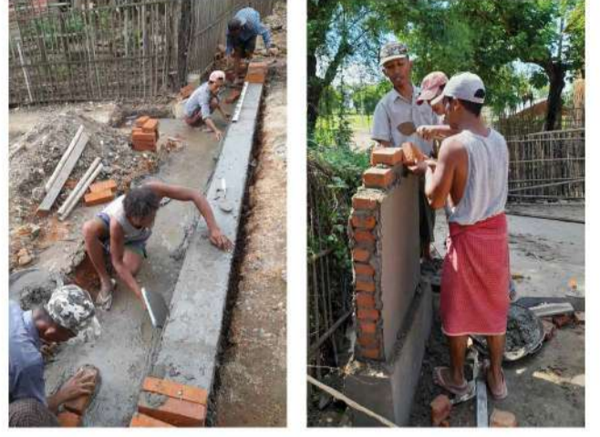
မန်ကျီးကျေးရွာရှိ အများသုံးလမ်းမကို ကွန်ကရစ်ခင်းခြင်းနှင့် ရေနုတ်မြောင်းတူးဖော်တည်ဆောက်ခြင်း
